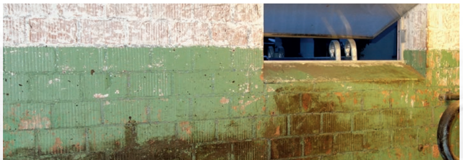
Der Stall musste vollständig von der PCB-haltigen Wandfarbe befreit werden. Alle Arbeiten wurden im Vollschutz und Unterdruck ausgeführt. Die Farbe wurde manuell mit oszillierenden Messern abgetragen.
