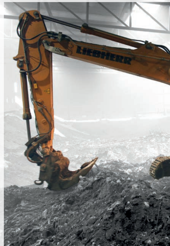
Sanierungsarbeiten bei der ehemalige Deponie «Pont-Rouge» in Monthey.
