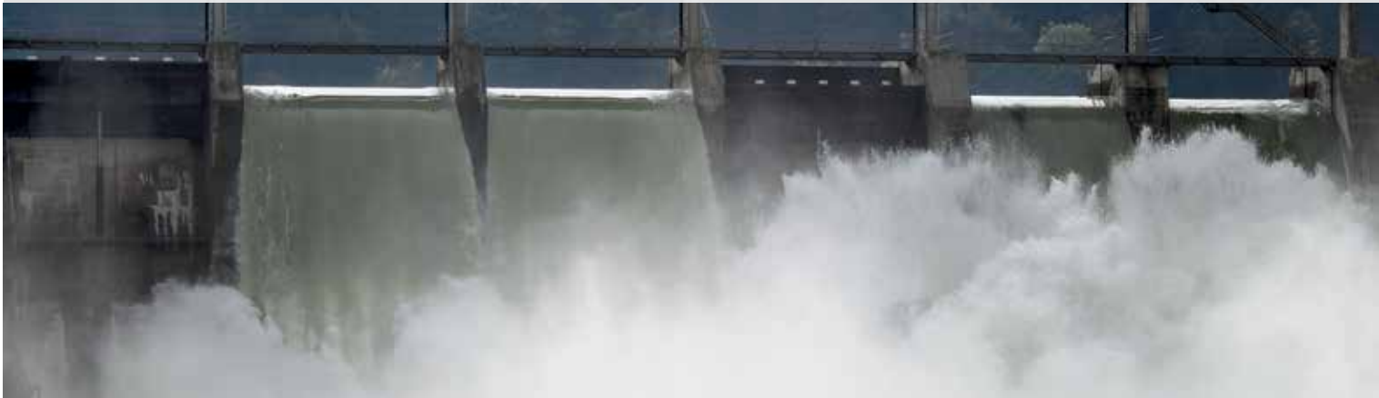
Staumauer des Wohlensee, unweit oberhalb des AKW Mühleberg.
