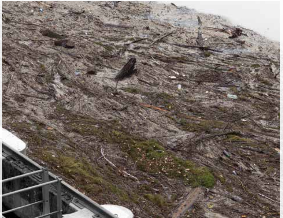
Angeschwemmtes Treibgut oder Totholz kann zum Verschluss eines Fließgewässers (sog. Verkläusung) und so zu einem Rückstau und steigendem Pegelstand führen. Das Werkgelände des AKW Mühleberg könnte in der Folge bis zu 80 cm überflutet werden. Schwemmmaterial hinter der Stauwand des Wohlensee. © Markus Kühni
