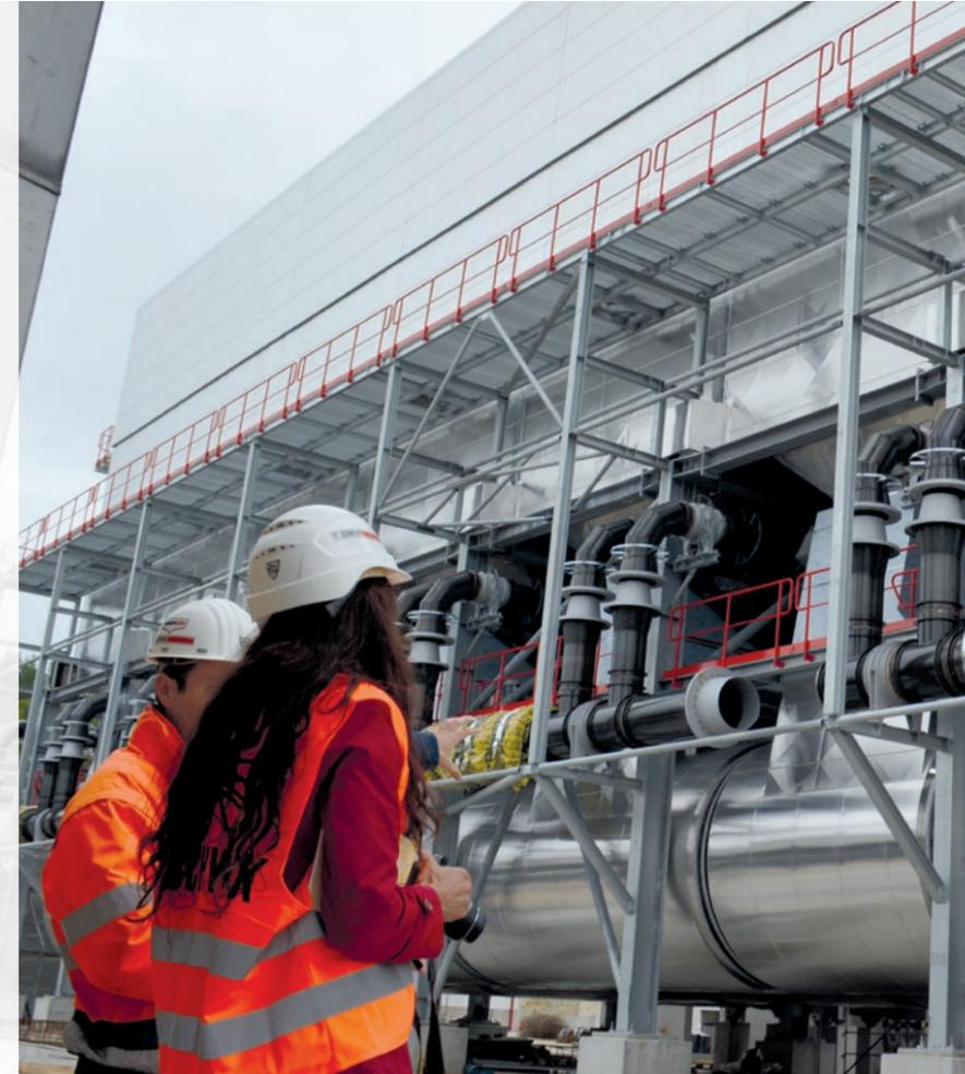
Die Zukunft der Abluftreinigung bei Zementwerken: Die neue DeCONOX-Anlage bei Schwenk-Zement in Allmendingen (D) senkt nicht nur den Ausstoss an Stickoxiden, sondern auch von problematischen organischen Schadstoffen.
