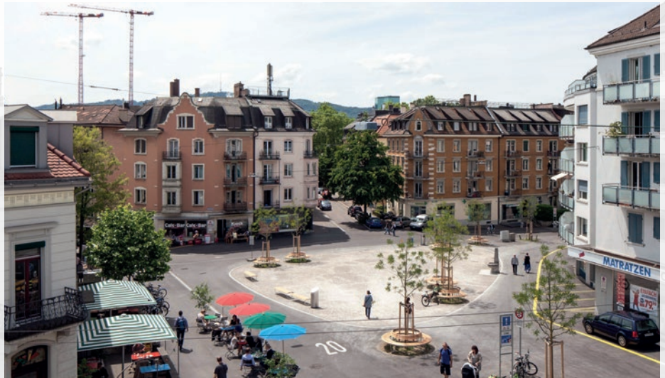
Verkehrsberuhigung erhöht die Lebensqualität: Hier mit einer Begegnungszone (Tempo 20 und Fussgängervortritt) auf dem Röschibachplatz, Quartierzentrum Wipkingen, Zürich.
