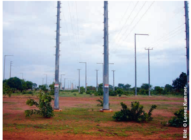
Der Ölboom im Tschad geht unvermindert weiter. Der Energieaufwand ist riesig. Stromleitungen zerschneiden das Land.
