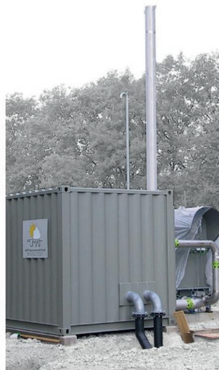
Aufbereitungsanlage für Methangas, das in Kohlendioxid und Wasser gespalten wird. © zvg
